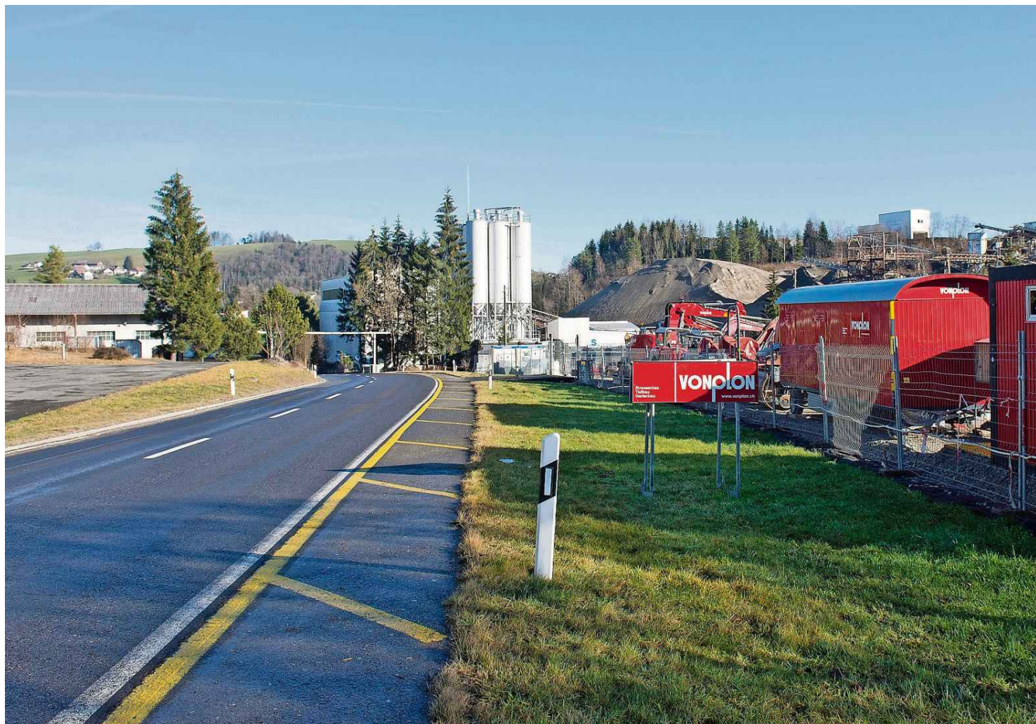
Der Installationsplatz für die Baustelle (rechts im Bild) ist bereits eingerichtet. Bild Maria Schmid
