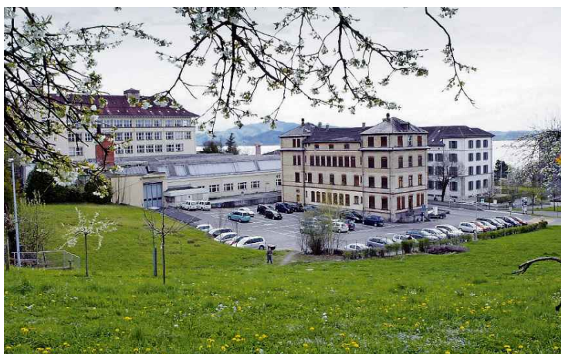
Auf diesem freien Grundstück wollte der Kanton Schulbauten errichten. Bild Werner Schelbert
