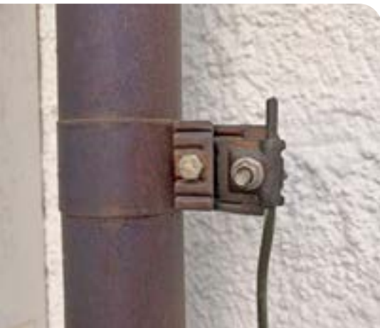
Über Ableitungen wird der Strom zur Erdungsanlage geleitet. (Bild: BFB)
