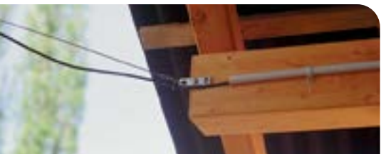
Gut ausgeführte Zaunzuleitung: Hochspannungskabel in schwerentflammbare Rohre verlegt. Zur Überführung im Freien ist ein Drahtseil als Stütze gespannt. (Bild: BUL)
