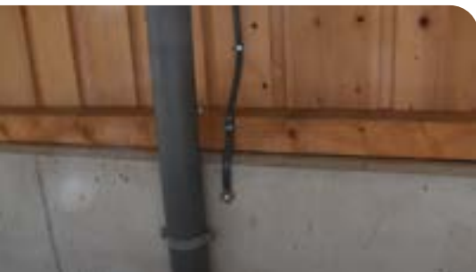
Verbindung der Ableitung an die Anschlussgarnitur (Bild: BUL)
