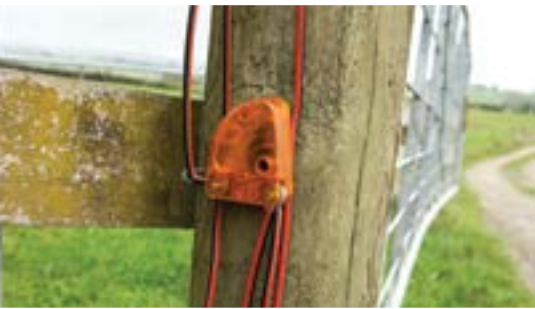
Spezielle Blitzschutzelemente in der Zaunzuleitung leiten den Strom aus Überspannungen zur Erde ab. (Bild: Gallagher)
