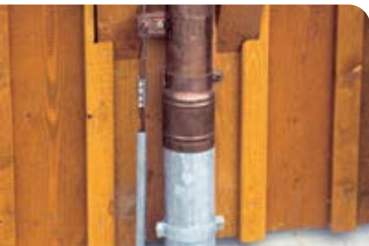
Eine regelmässige Sichtkontrolle des Blitzschutzsystems und der Verbindungen ist erforderlich. (Bild: BUL)
