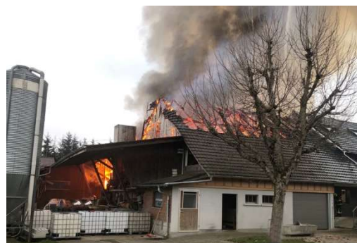
Hier kam es zu einem Brand, weil beim Pressen in der Scheune Heu aus der Zange des Heukrans auf das Verlängerungsrohr des heissen Traktor-auspuffs fiel. Bild: KAPO LU
