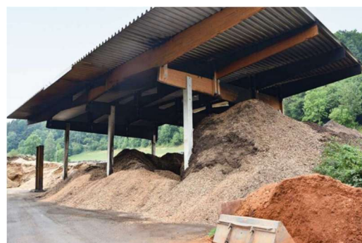
Von einem Brand betroffenes Holzhackschnitzellager. Hier kam es aufgrund hoher Lagerhöhen (etwa 7 – 10 Meter) zur Selbstentzündung des Hackguts. (Bild: IFS/Schallmoser*)
