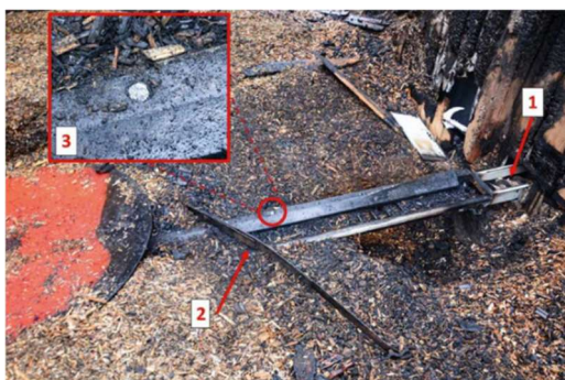
Reib- und Schlagvorgänge können Funken bilden und Brände auslösen. Hier die Situation nach einem Brand: 1) Ausserhalb des Bunkers sind in der Austragung keine verkohlten Hackschnitzel vorhanden. 2) Federblattarm, der über den Boden streift. 3) Schraubenkopf mit offensichtlichem Materialabtrag. (Bild: IFS/Schallmoser*)
