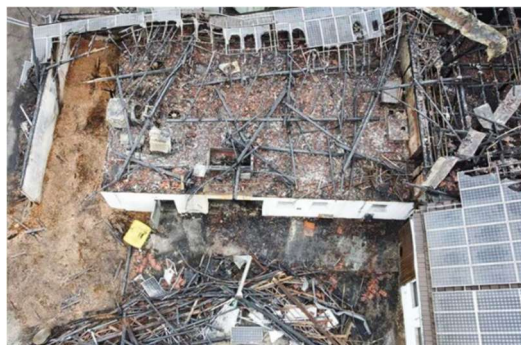
Drohnenaufnahme eines landwirtschaftlichen Gebäudes nach einem Brand, ausgehend von einem Holz hackschnitzellager. (Bild: IFS/Schallmoser*)
